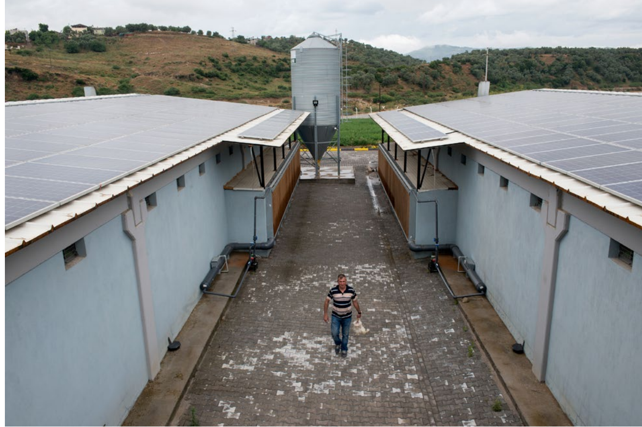
Aydın'da bir tavuk çiftliği, kümes çatısına 500 KW kapasiteli 2.000 adet güneş paneli kurdu. © Mathias Depardon pour l'Agence Française de Développement.
