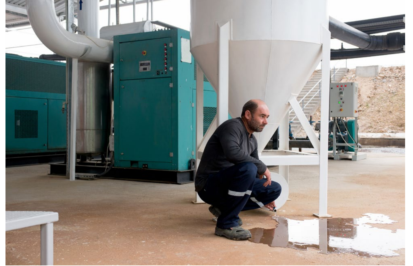
Biyogaz, günde 450 ton hayvan gübresinin doğal fermantasyonu sonucu elde edilmekte ve günlük 2.4 MW elektrik üretimi ile 5.500 kişinin ihtiyacı karşılanmaktadır. © Mathias Depardon pour l'Agence Française de Développement
